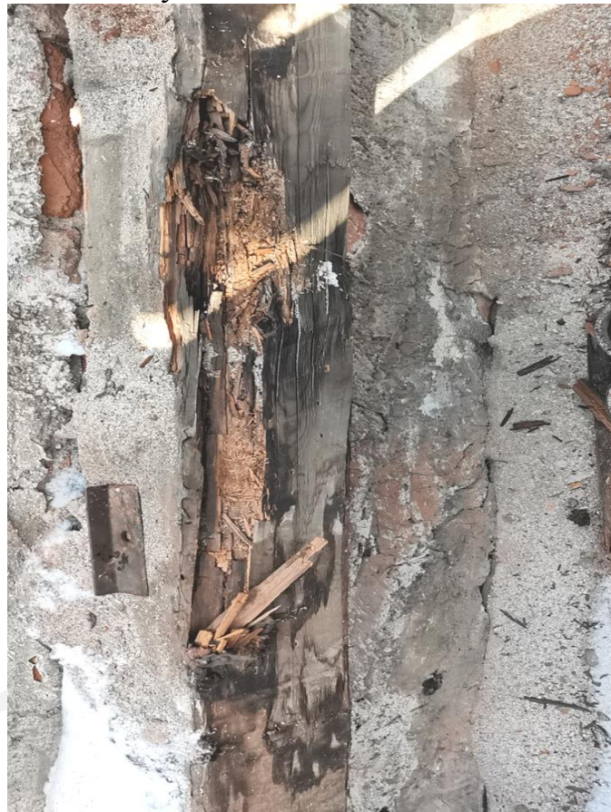
8. Záklop napadnutý hnilobou
