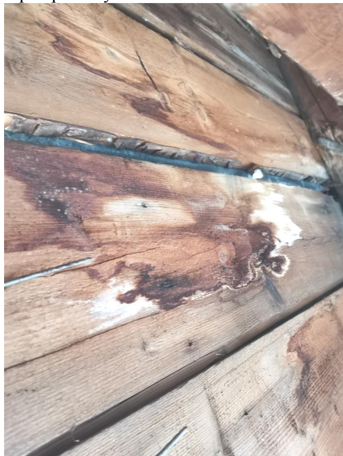
8. Záklop napadnutý hnilobou
