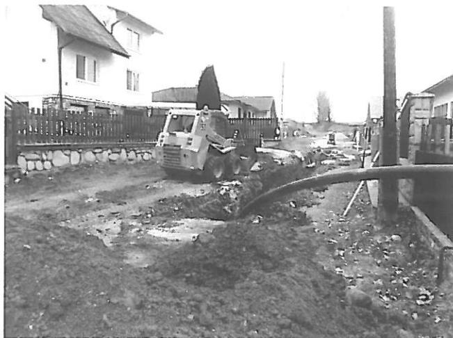
Výstavbu spláškovej kanalizácie mesto realizuje aj na Popradskej ulici (v Strážkach) v rámci projektu EÚ „Environmentálna infraštruktúra Spišská Belá - splášková kanalizácia“
