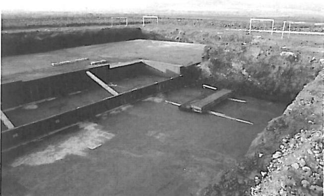
„Mesto v súčasnosti realizuje aj rozšírenie súčasného vodojemu na Mišom vršku v rámci projektu EÚ „Environmentálna infraštruktúra Spišská Belá - vodovod“, ktorý zväčší súčasný vodojem na štvornásobok (na objem 2 x 600m3)
