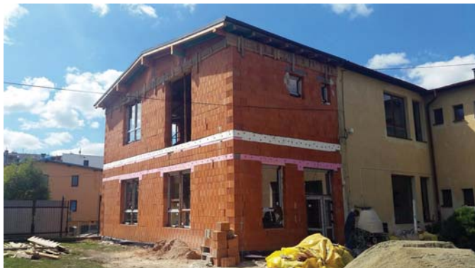
• Prístavba k budove ZŠ na Štefánikovej ulici - stav k 23. 8. 2016 - jej úplné nedokončenie však neohrozilo začiatok nového školského roka.
