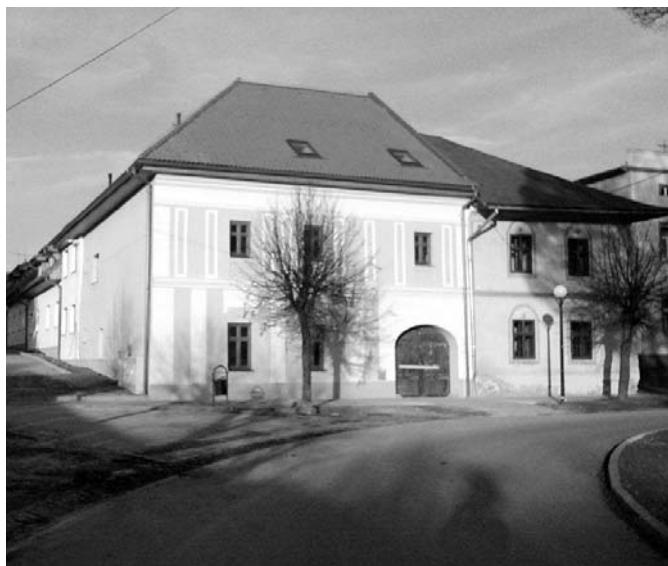
• Meštiansky dom na Štefánikovej č. 18 so 17 nájomnými bytmi.
