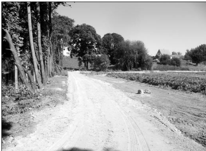
• Výstavba cyklotrasy v Strážkach pri kaštieli
