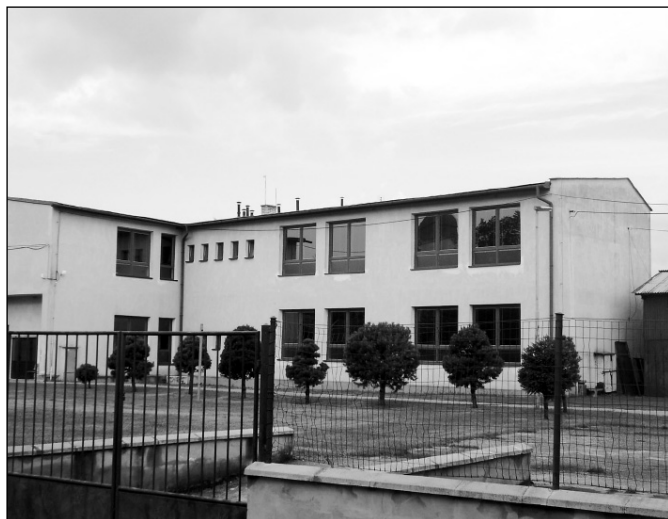
• Počas letných prázdnin sa na budove Základnej školy na Štefánikovej ulici 19 vymenili okná a vstupné dvere za plastové.
