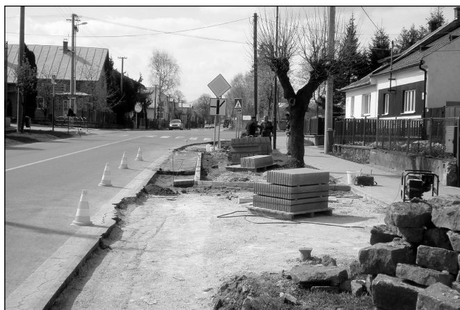
• Stavebné úpravy vjazdov a dažďového rigola na Ul. kpt. Nálepku.
