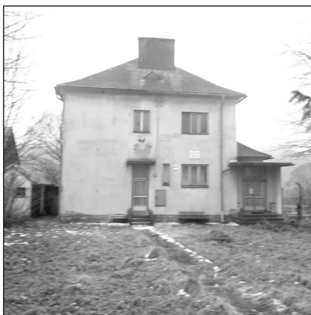
• Bývalá materská škola
