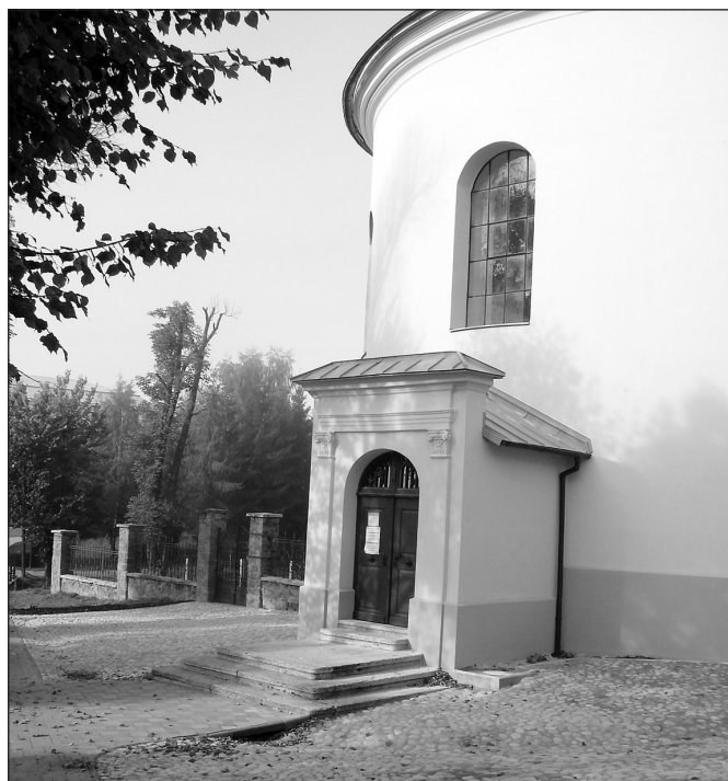
• Mesto skončilo terénne úpravy okolia evanjelického kostola. Kamenná valúnová dlažba veľmi vkusne doplnila celkový pohľad na evanjelický kostol a jeho novú fasádu. Už len čo najskôr upraviť park, ktorý sa nachádza oproti a prilahlú záhradu, a prípadne inštalovať nočné osvetlenie kostola.
